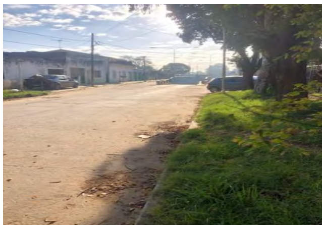
Figura 28: Calle 105 y 17 de Octubre hacia Paso bajo nivel
